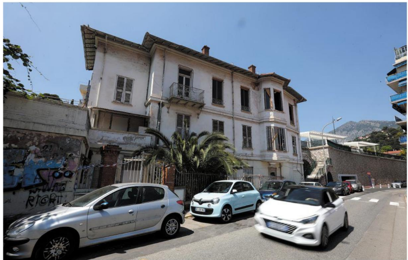
L'hôtel Le Chouchou, futur lieu d'accueil de ce centre, est à deux pas de la gare de Menton. PHOTO CYRIL DODERGNY
